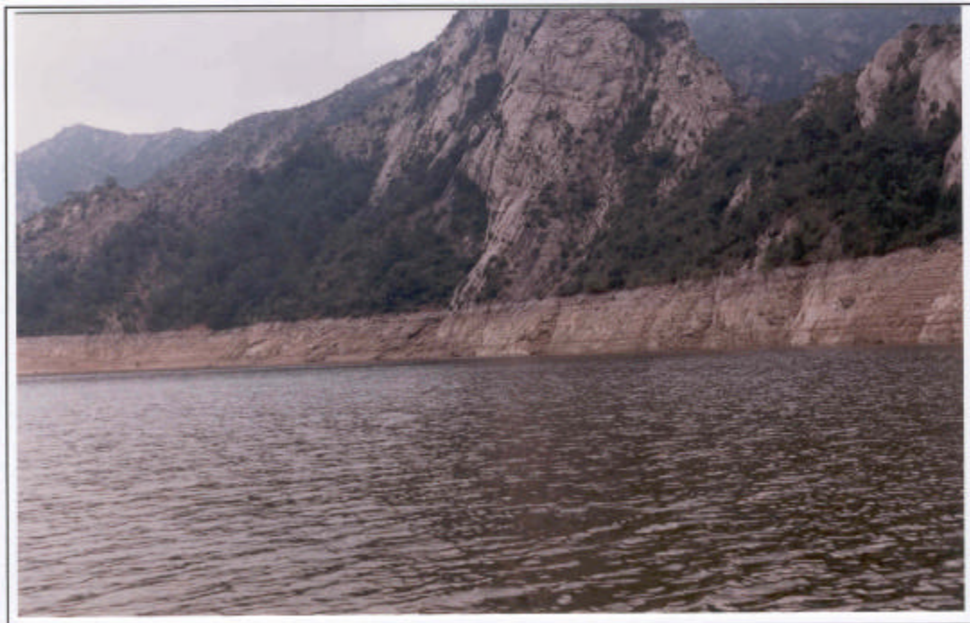
Embalse de Oliana. Obsérvese la zona de fluctuación de nivel del agua.
