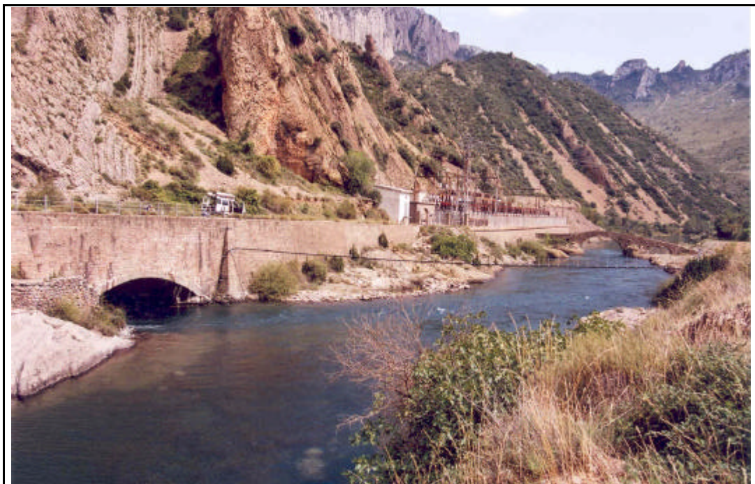
Foto 1. Vista del aliviadero de la presa de Escales (4-09-2002).
