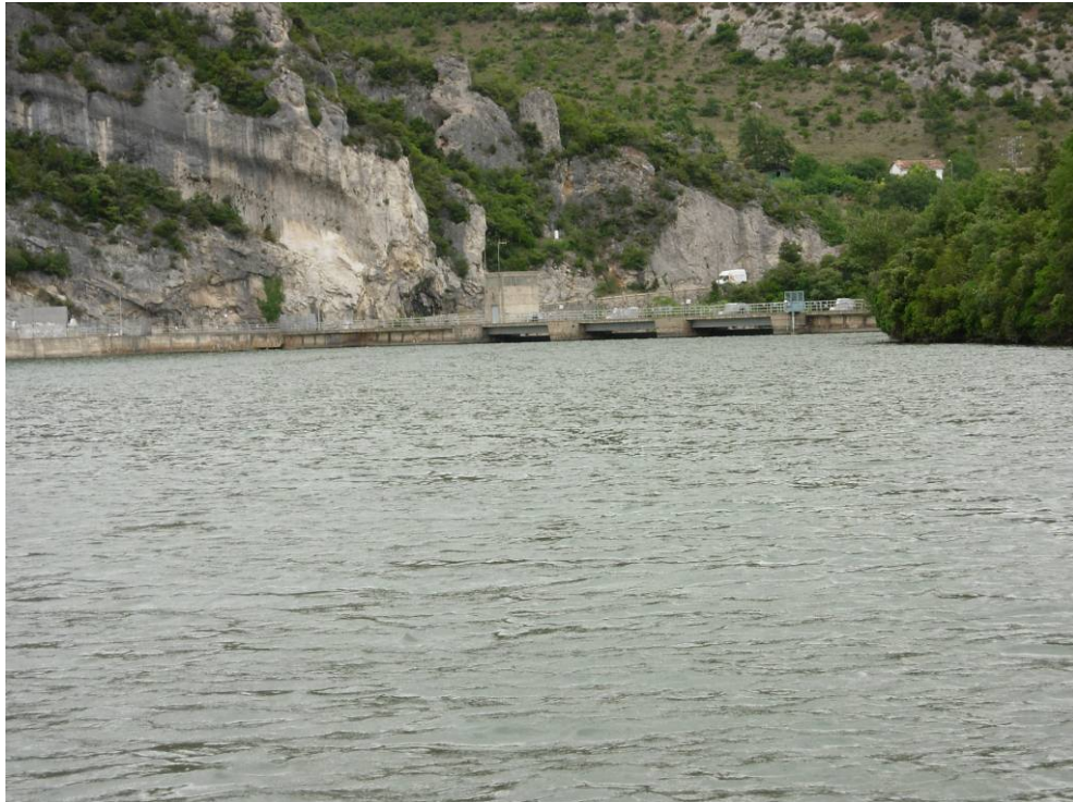
Vista de la presa desde la estación de muestreo (E1). Verano de 2005 (05/07/2005)
