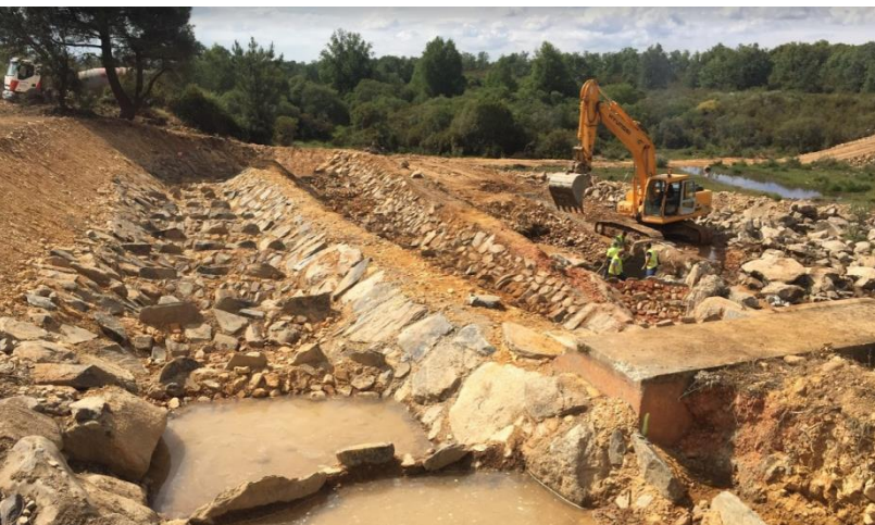
Construcción de dispositivos de paso de peces
