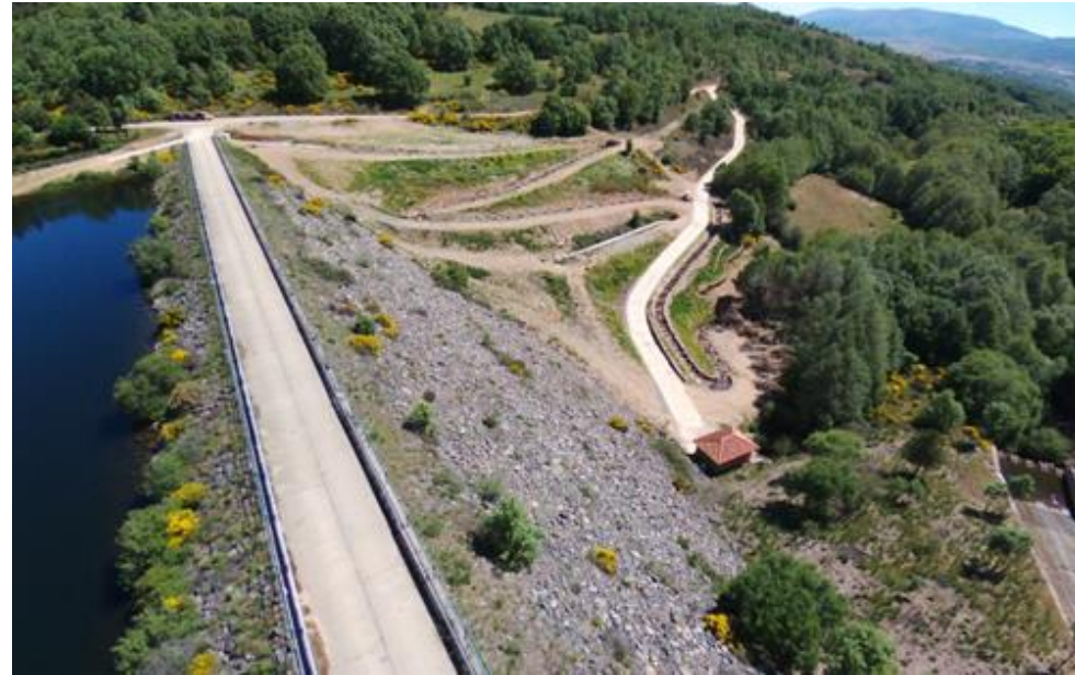
Experiencia piloto para la permeabilización de una gran presa
