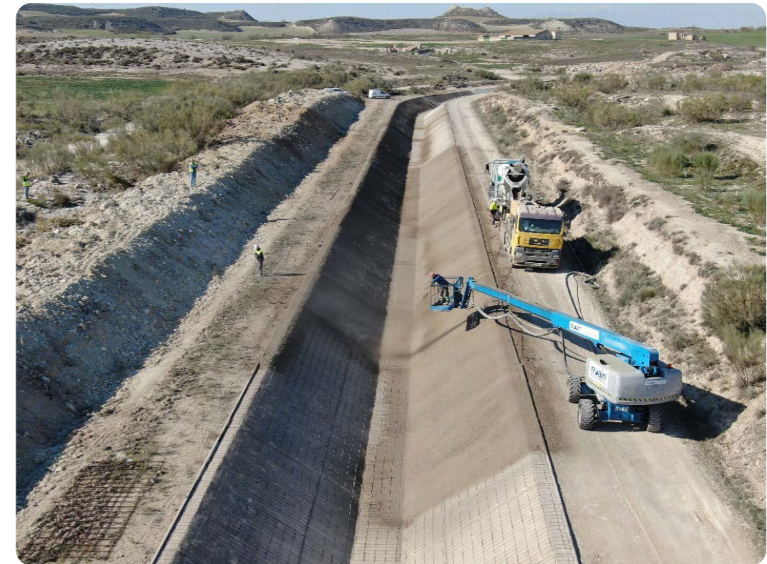
Mejora de una de las acequias del canal de Bardenas.
