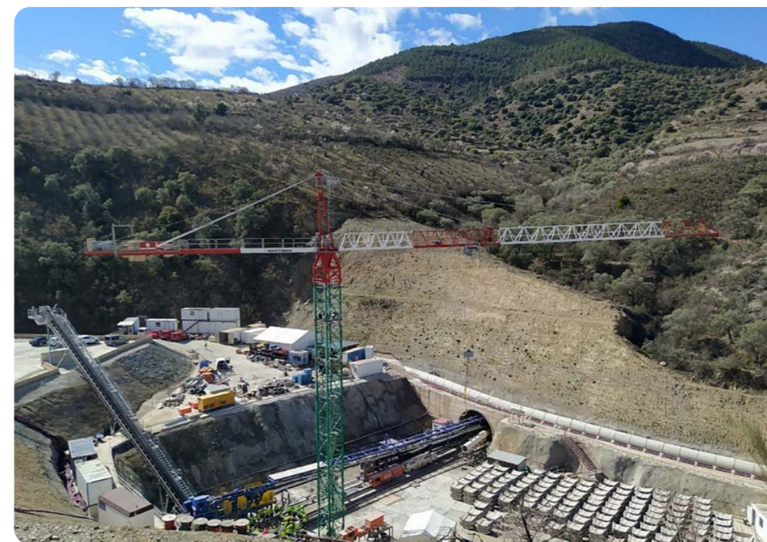
Obras de la Presa de Mularroya, azud de derivación y conducción de trasvase.
