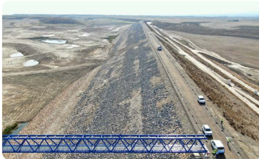
Vista de dique oeste hacia estribo sur.
