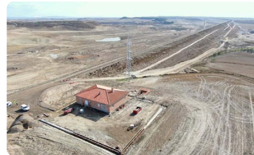
Vista del dique oeste y su edificio de Administración.
