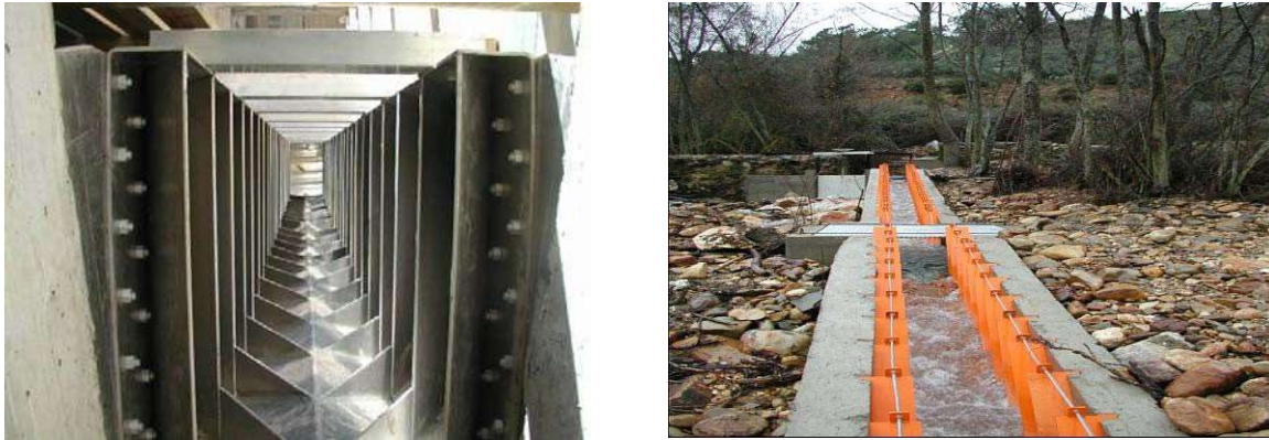
Fig. 38. Detalle del interior de una denil (izq.) y vista de una rampa Denil con una artesa de descanso en el río Zayas (León). Fuente: Sanz Ronda
