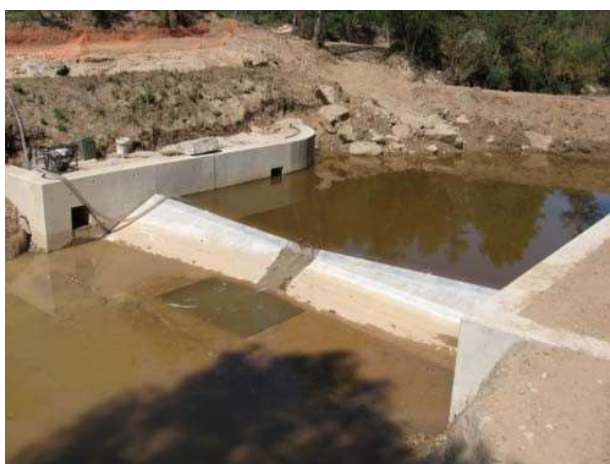
Fig. 5. V-Flat con estanque aguas abajo (Cataluña)
