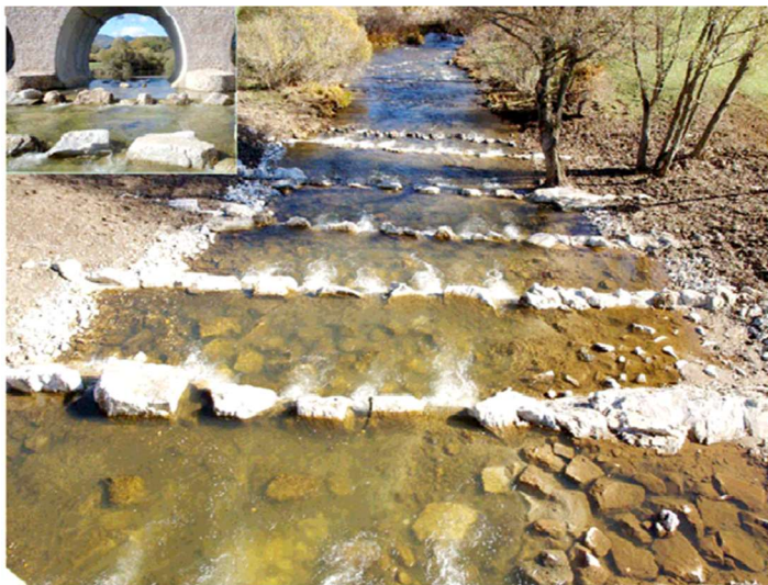
Fig. 24. Vista de una rampa de piedras en el río Pisuerga (Burgos). Fuente: Sanz-Ronda
