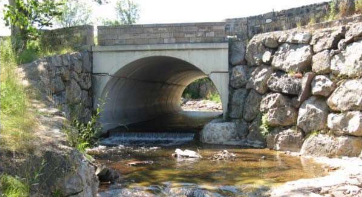
Fig. 7. Estructura transversal construida con un caño semicircular en un afluente del río Hajar (Cantabria)
