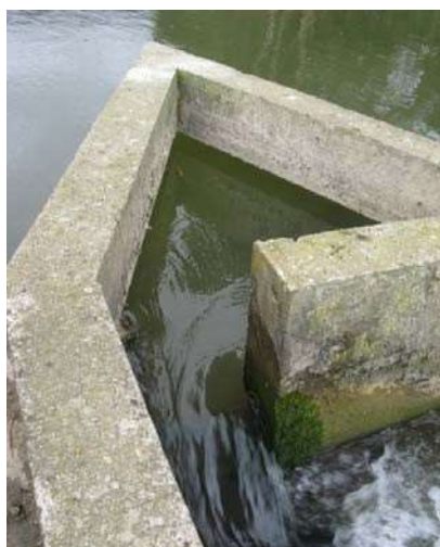
Fig. 32. Salida de una escala de peces protegida por una cuña en el río Arakil (Navarra)
