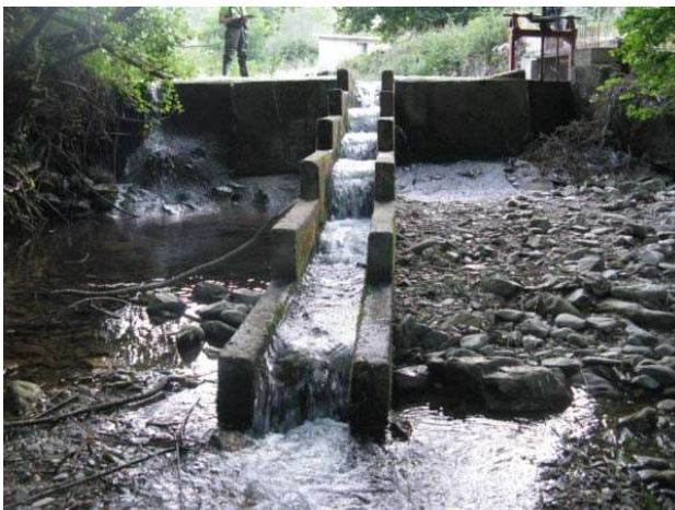
Fig. 15. vista de una escalera de artesas de vertido libre en el río Cardenas (La Rioja)
