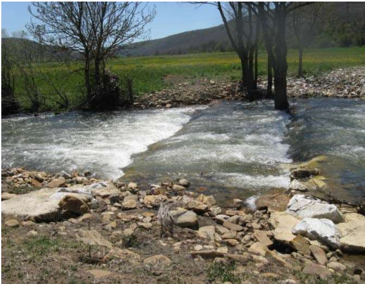
Fig. 46. Vista de una poza de una rampa de piedras del tipo rápido-remanso
