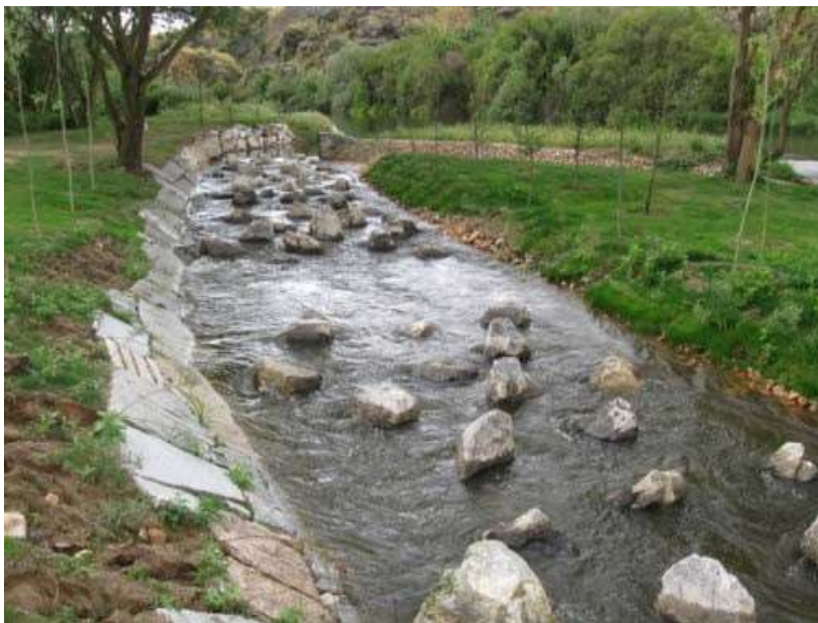
Fig. 40. Detalle de bloques de piedra en un río artificial. Fuente: Sanz-Ronda
