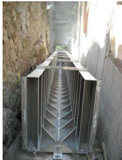
Fig. 22. Vista de un ralentizador tipo Alaska. Fuente: www.1.bp.blogspot.com
