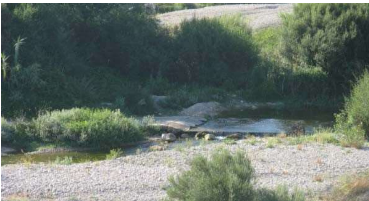
Fig. 9. Vado a nivel del cauce en el tramo medio del río Matarraña (Teruel)
