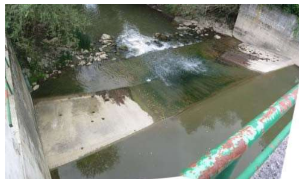
Fig. 6. V-Flat sin estanque aguas abajo en el río Arakil (Navarra).
