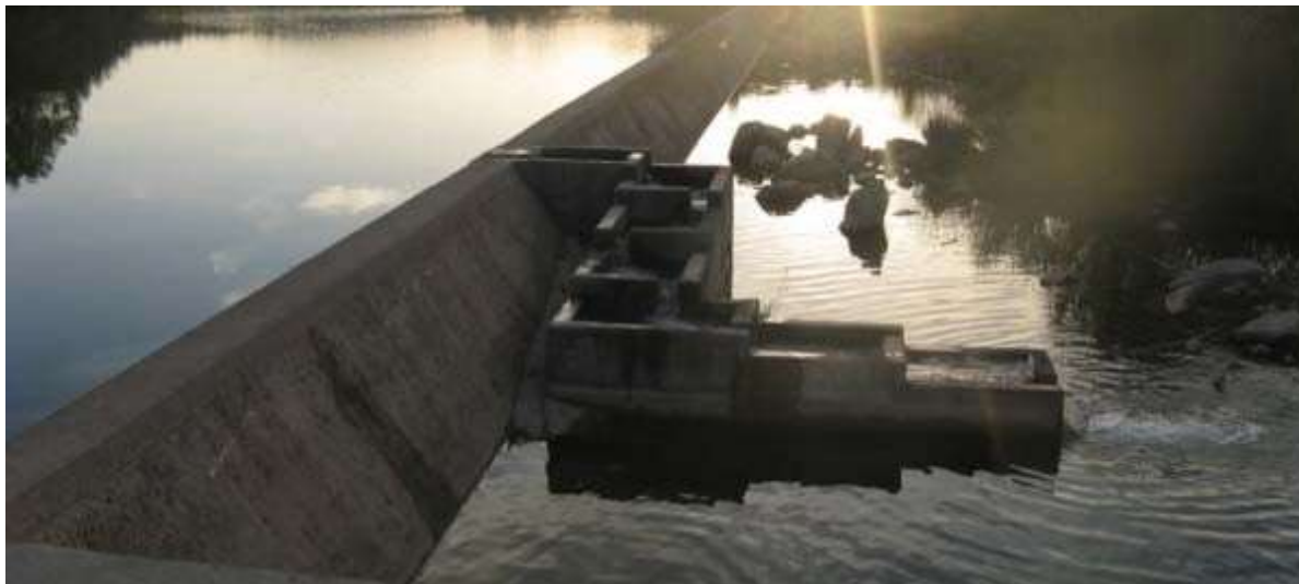
Fig. 2. Vista de un azud para derivación en el tramo bajo del río Matarraña (T.M. Maella, Zaragoza) que cuenta con escala de peces de artesas en vertido libre.
