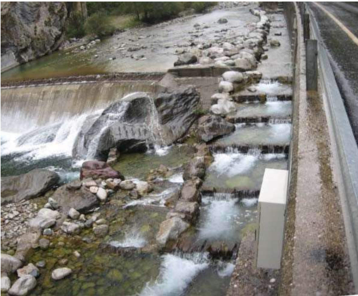
Fig. 17. Escala de peces en la toma de la Central de Salinas, en el río Cinca (Huesca). Este paso se corresponde con una escala de artesas sucesivas en vertido libre. Se trata de un paso funcional para salmónidos.
