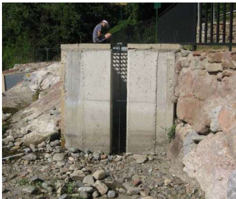
Fig. 36. Hendidura vertical en la salida de la escala por la que entra el caudal a la escala. Río Oja (La Rioja)
