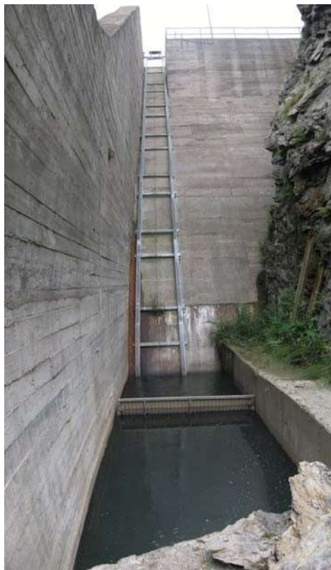
Fig. 13. Vista del ascensor en la central hidroeléctrica en el río Santa Magdalena (Lérida)
