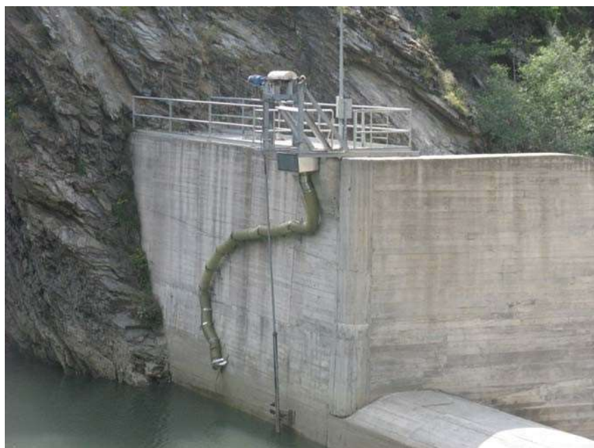
Fig. 14. Vista del grupo elevador y del canal de desagüe. Río Santa Magdalena (Lérida)
