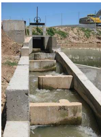
Fig. 16. Vista de una escalera de artesas de vertido semisumergido en el río Duero (Guma)
