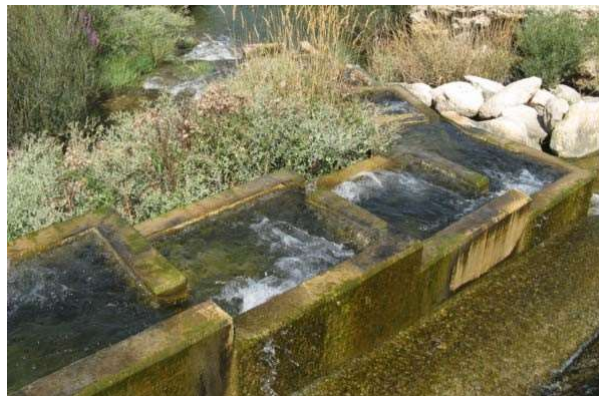
Fig. 37. Foto escala mal dimensionada en el río Matarraña (Teruel).
