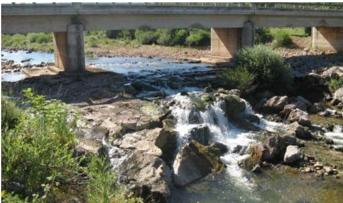
Fig. 10. Vista de un puente cuya solera se ha quedado descolgada del nivel del río Híjar (Cantabria), produciéndose un salto de aguas debajo de esta infranqueable para la migración de los peces aguas arriba
