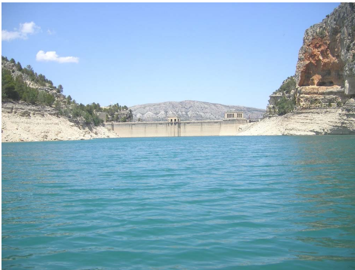
Foto 1: Vista general del embalse y la presa desde el punto de muestreo
