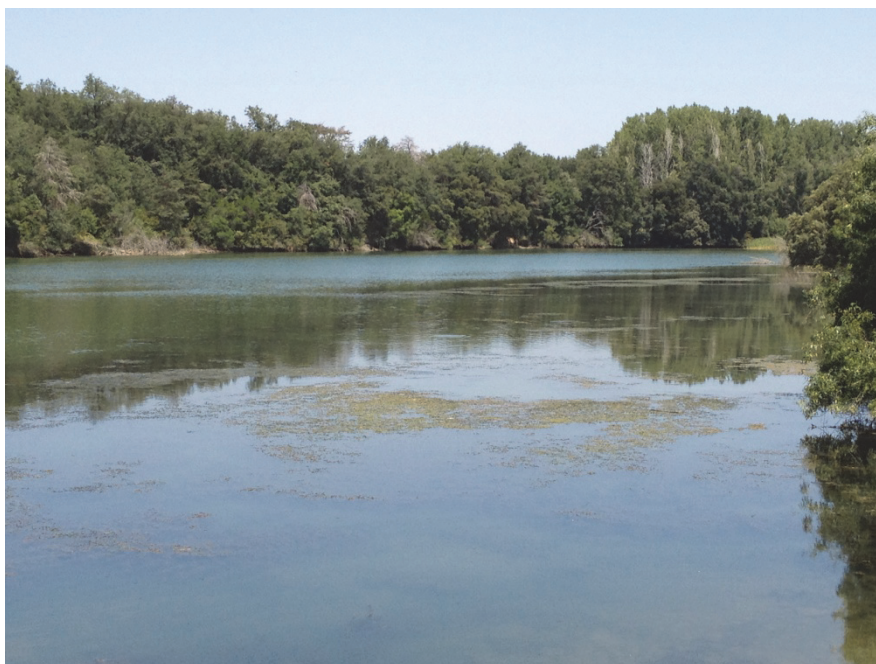
Figura 3: Vista desde la presa hacia aguas arriba
