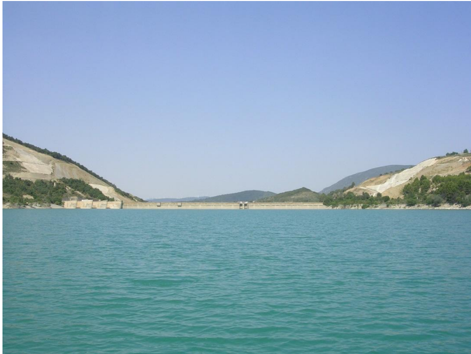
Figura 7. Vista de la presa del embalse
