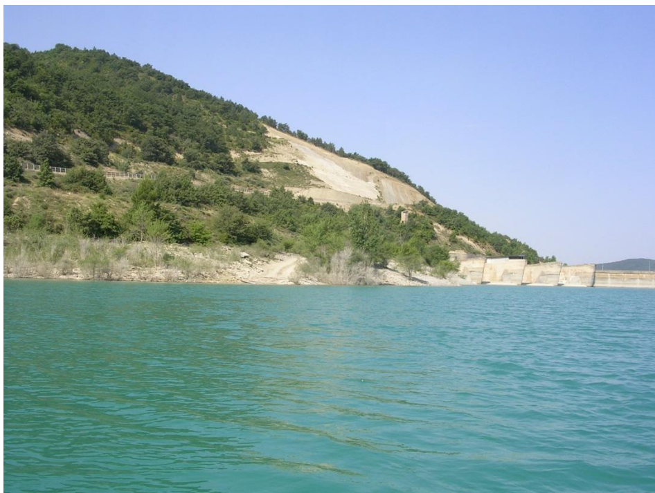
Figura 8. Vista del punto de acceso
