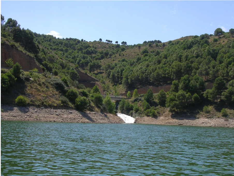
Figura 9. Vista de la entrada del trasvase del río Queiles.
