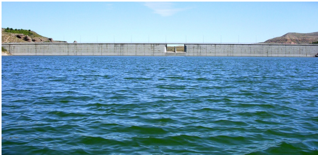
Figura 7. Vista de la presa del embalse.
